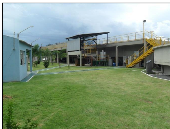
Figura 55 – Vista da ETE Alegria
