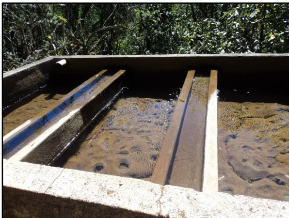
Figura 50 – Unidade de filtração
