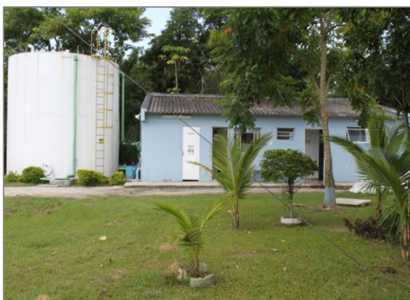
Figura 23 – Vista da ETA São Caetano
