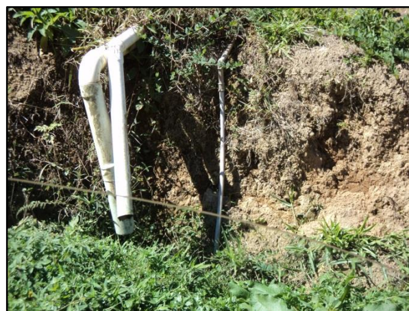
Figura 70 – Lançamento do esgoto da localidade de Rio Preto
