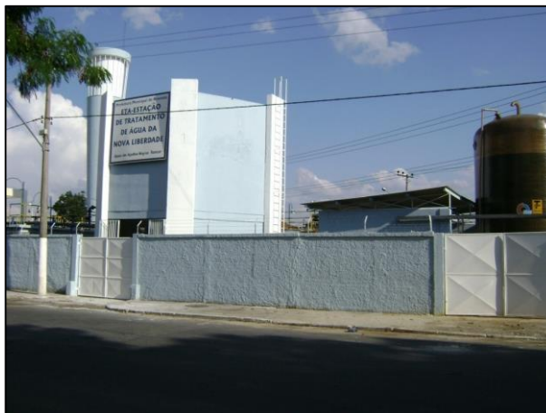
Figura 7 – ETA Nova Liberdade
