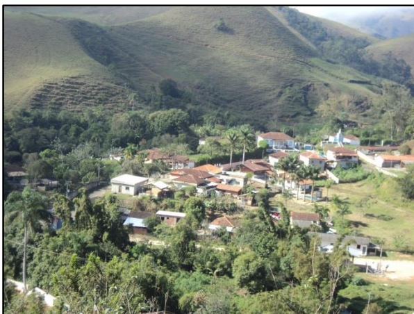
Figura 35 – Vista do núcleo urbano do distrito de Fumaça
