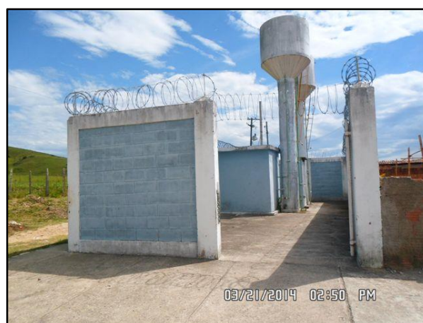
Figura 28 – Acesso a ETA Morada das Rosas
