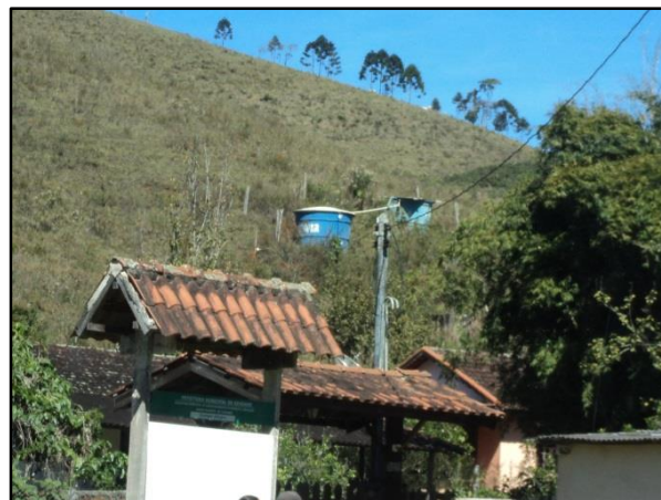
Figura 42 – Vista das unidades de reservação
