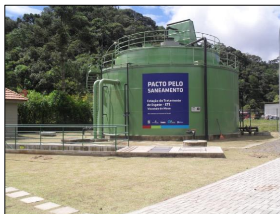
Figura 66 – Unidade de Tratamento
