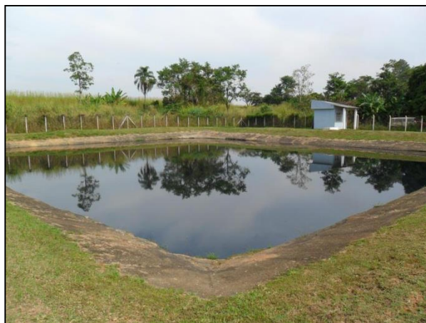
Figura 61– Lagoa anaeróbia da ETE Isaac Politi
