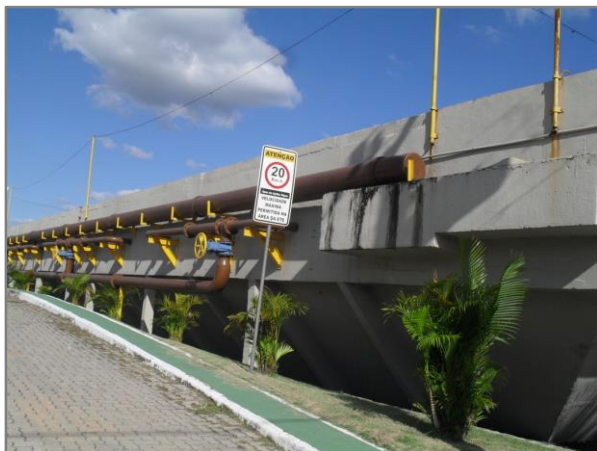
Figura 58– Vista da estrutura da ETE Alegria.
