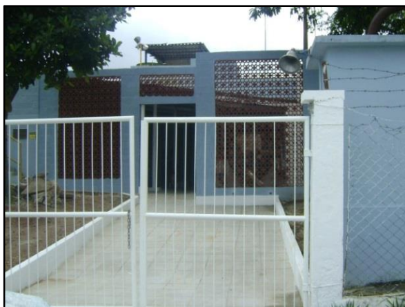
Figura 17 – Visão da entrada - ETA 31 de Março.
