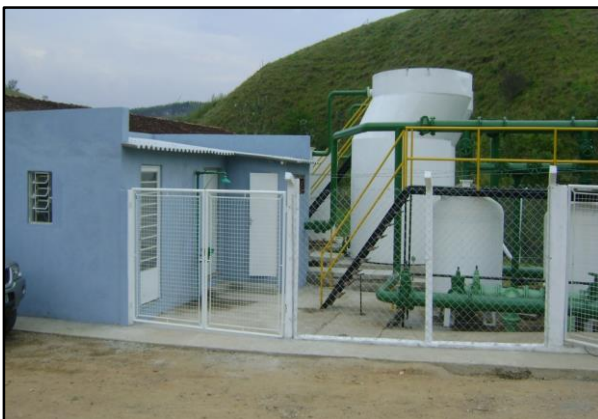
Figura 30 – Acesso a ETA Engenheiro Passos
