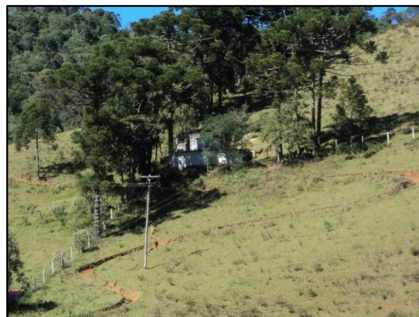
Figura 49 – Unidade de tratamento
